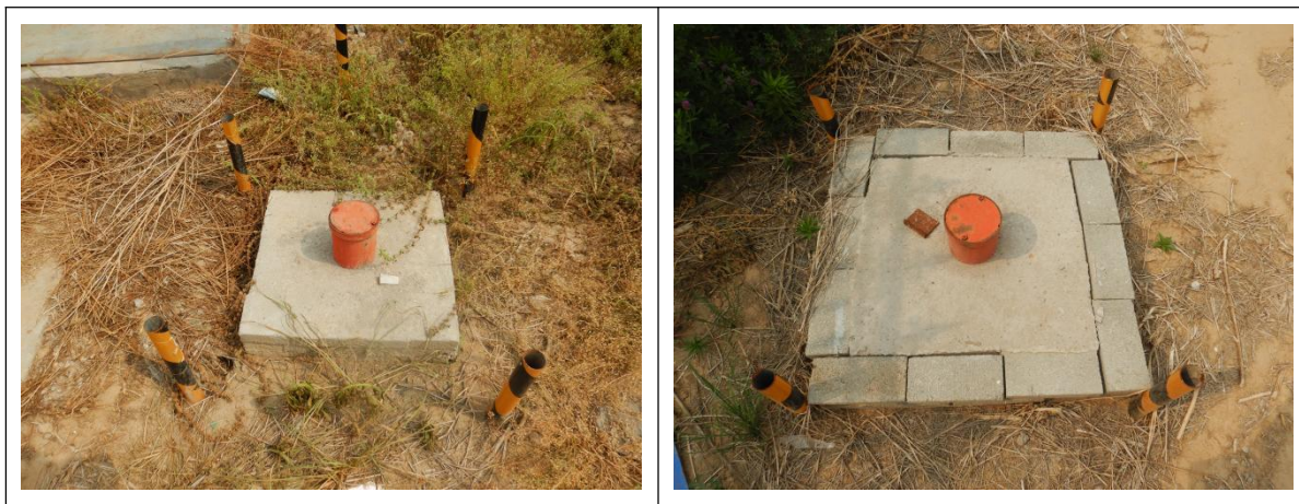
图 7.4-1 现有地下水井现状
