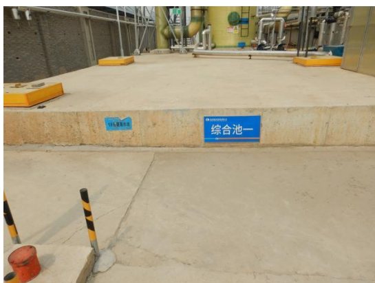
初期雨水收集池
